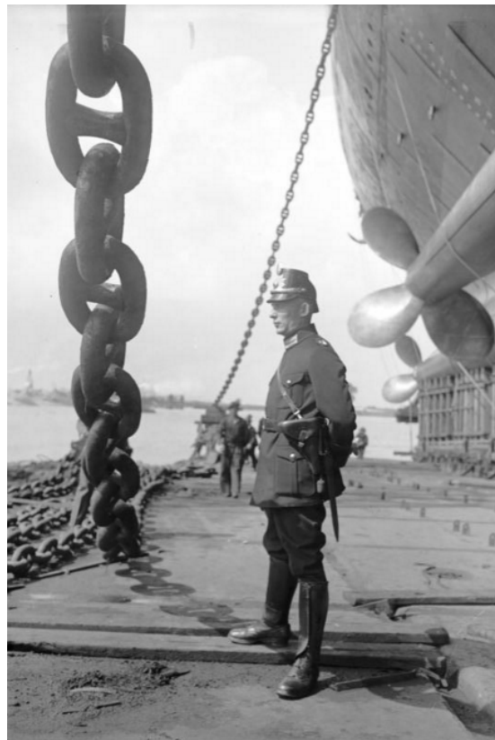
Рисунок 1. Цепи, используемые при штабелировании парохода "Бремен". Фото из Федерального архива Германии. Bundesarchiv Bild 102-06406, Bremen, Stapellauf des Dampfers "Bremen"
